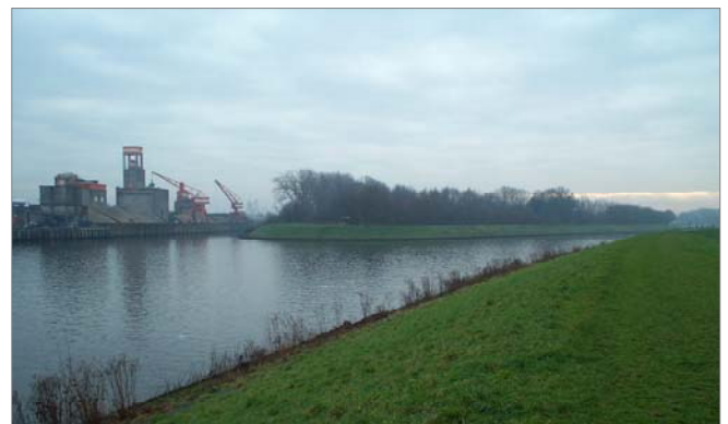
De plaats waar de fietsbrug moet komen te liggen.
